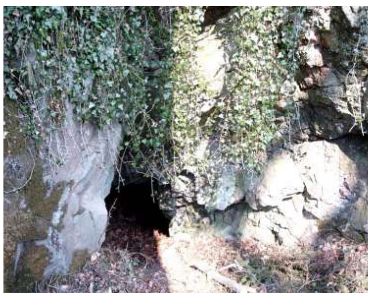
Auch im „Stollenbau“ folgte man an verschiedenen Stellen dem eisenhaltigen Gestein ins Innere der Berge. Unser Foto zeigt das Stollenmundloch am sog. „Dachsbau“ bei Wenningen. Der Stollen selbst ist verschüttet.
